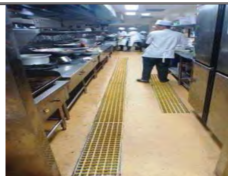
ในห้องครัว เปลี่ยนแทนฝาเดิม น้ำหนักเบา
