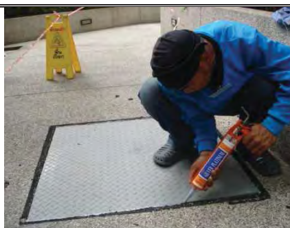
เปลี่ยนฝาเหล็กสนิมออก ใช้ฝา FRP ใหม่
